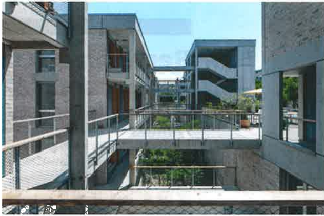
Brücken führen auf die Laubengänge der seeseitigen Wohnhäuser und über den tiefer liegenden Hof.
